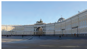
Здание «Главный штаб и Министерства», в котором находится Военная историческая библиотека Генерального штаба Вооруженных Сил Российской Федерации.
