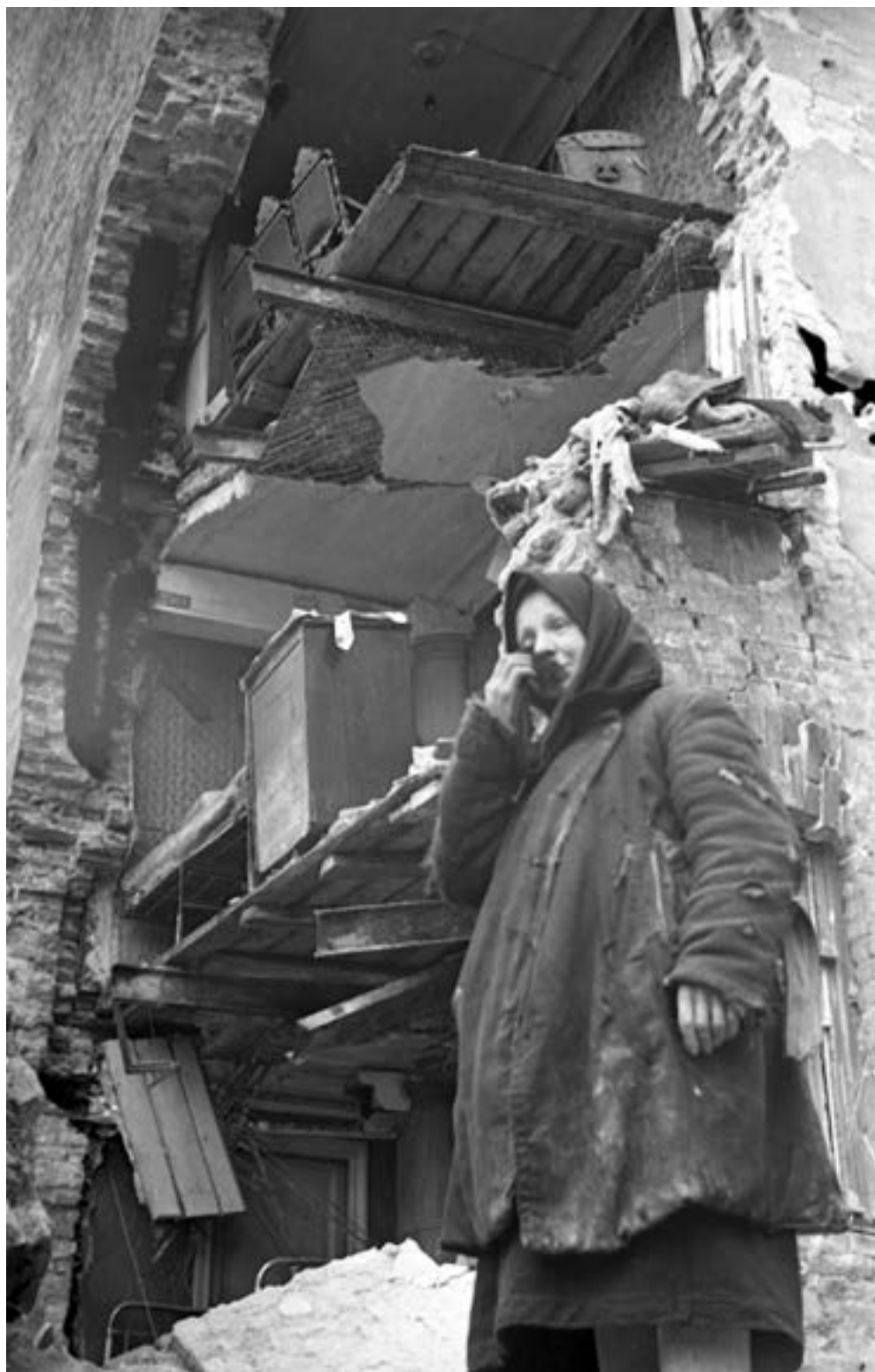
Жительница Ленинграда у разрушенного дома. 1943 г.
