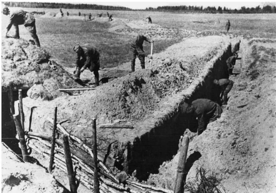
Строительство оборонительных сооружений на Курской дуге
